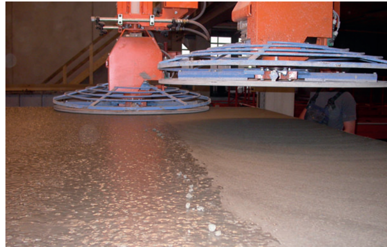
Fig. 6: Post-traitement de la face de parement au moyen de truelles mécaniques
