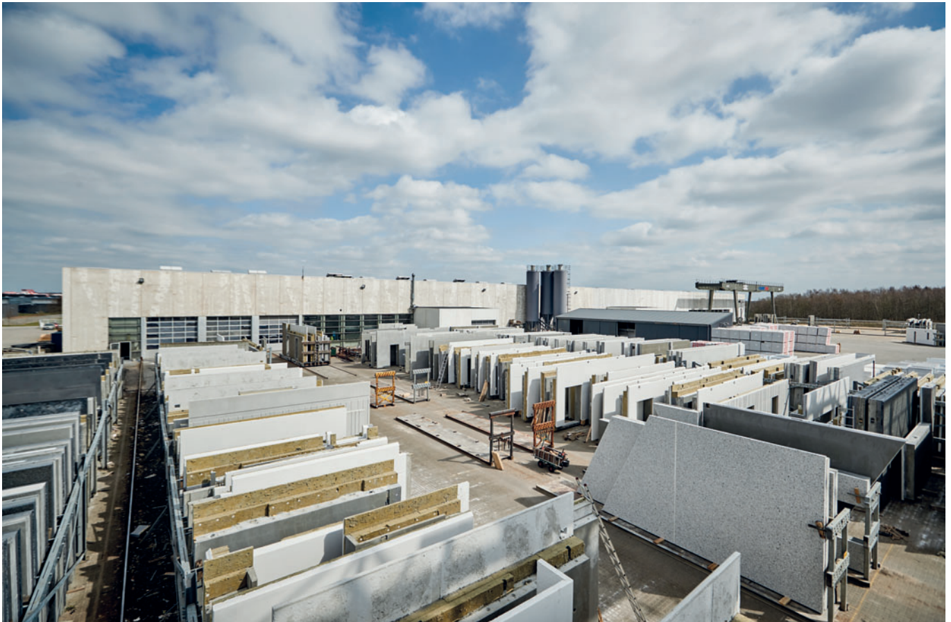
Fig. 2: Vue sur l'entrepôt extérieur; au fond, les deux halles de fabrication, avec la centrale à béton au centre.
