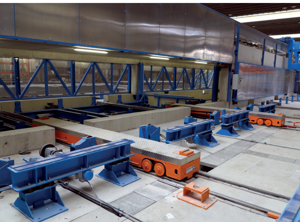
Центральная передвижная платформа с поперечно-подъемным механизмом при подъезде к станции виброуплотнения
