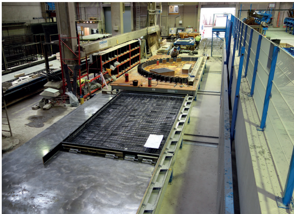
Опалубочно-арматурные станции для стеновых сэндвич-панелей и специальных элементов
