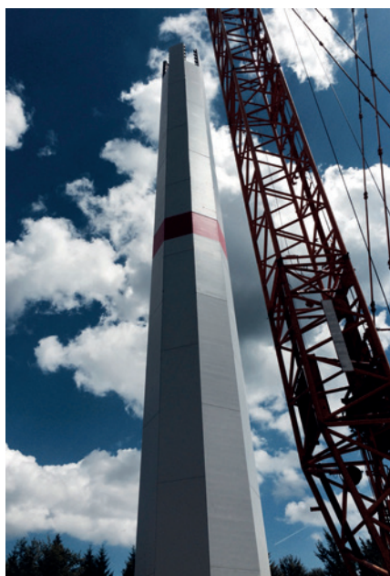
Запатентованная гибридная башня Ventur для ветрогенераторов
