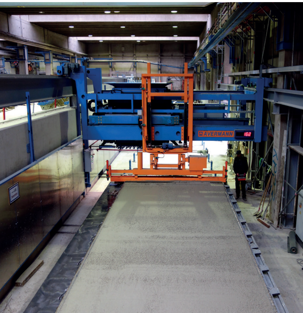
Крановый бетонораздатчик с заглаживающим устройством
