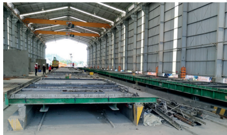
В производственном цехе смонтированы две параллельные линии, состоящие в общей сложности из 16 поворотных столов
