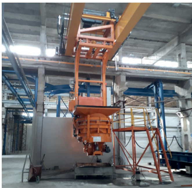
Монтаж бетонораздатчика на кран
