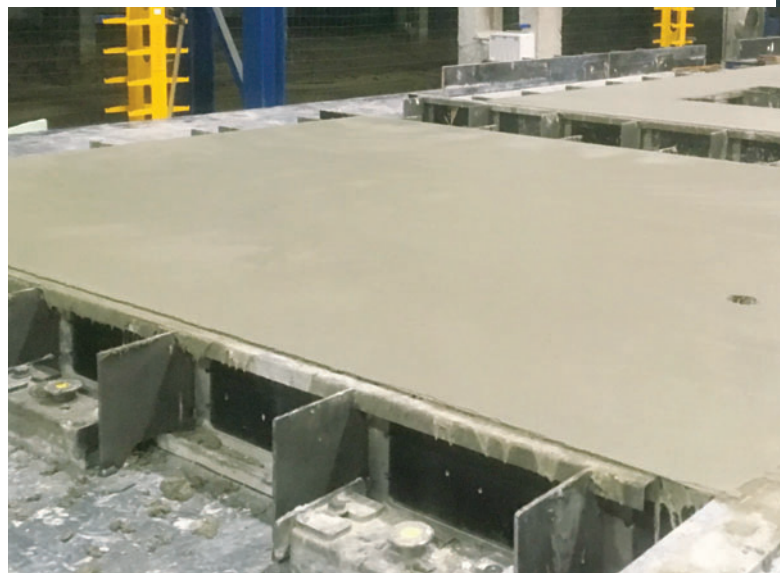
Бетонный элемент с заглаженной поверхностью
