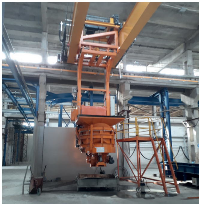
Rozścielacz mieszanki betonowej podczas podczepiania do suwnicy.
