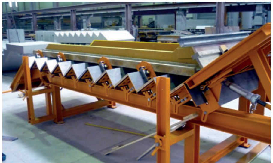
Fig. 2: Fabrication d'un escalier standard
