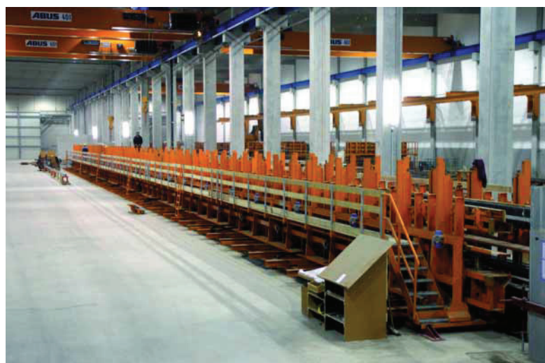
Общий вид универсальной опалубки длиной 99 метров
