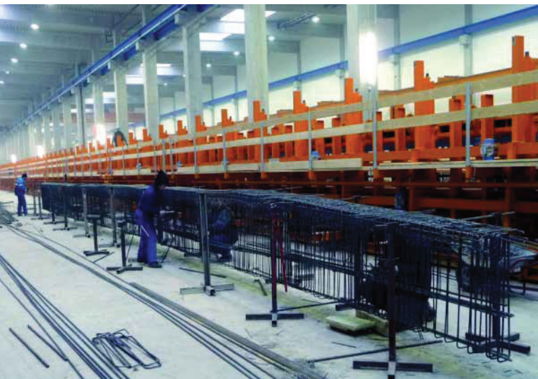
Процесс изготовления арматурного каркаса
