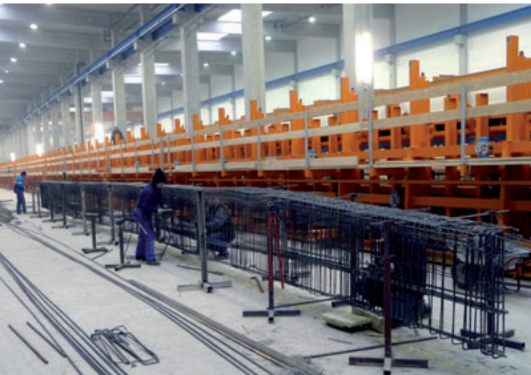
Construcción de la jaula de armadura
