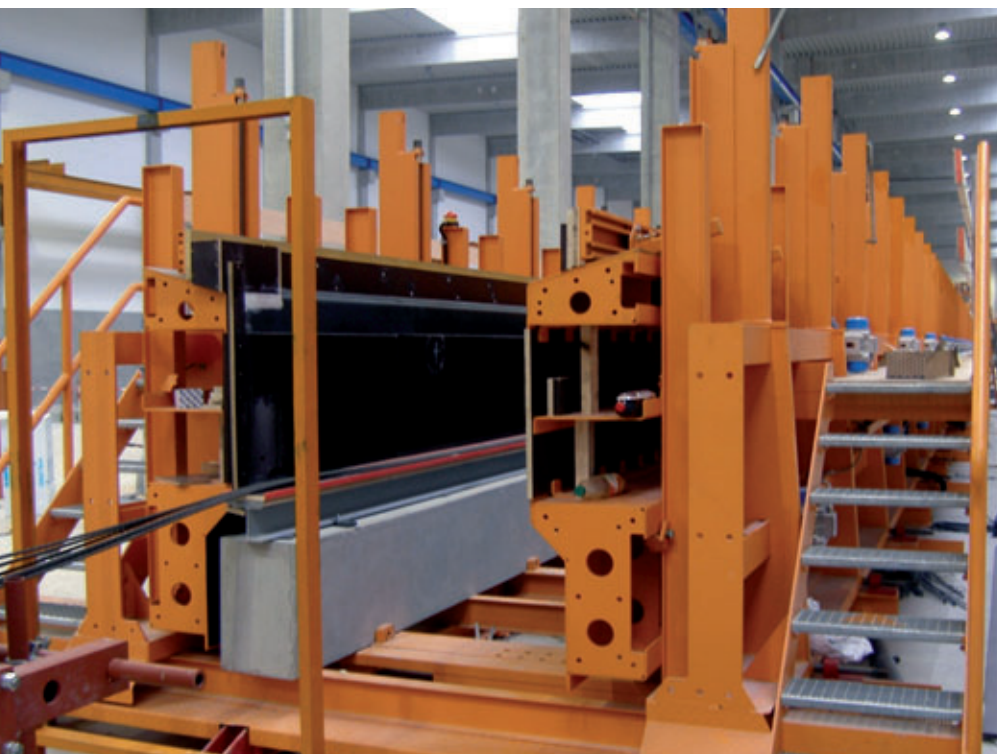
Encofrado con piezas suspendidas para vigas
