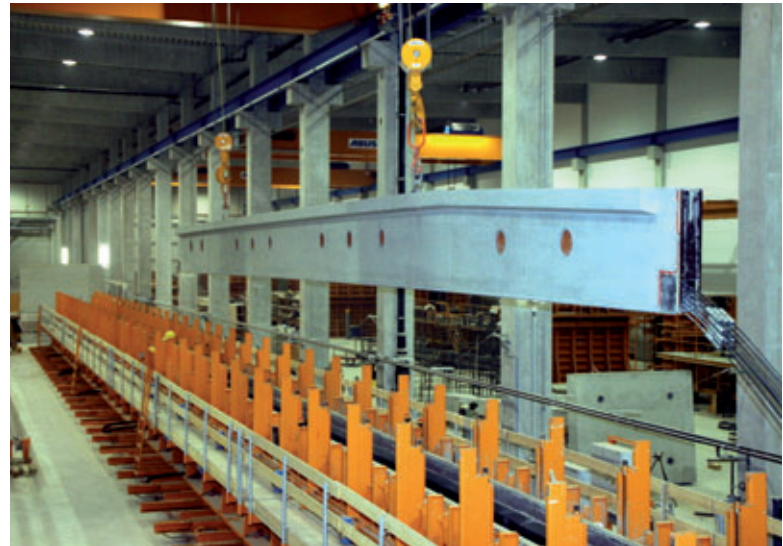
Izado de una viga a dos aguas
