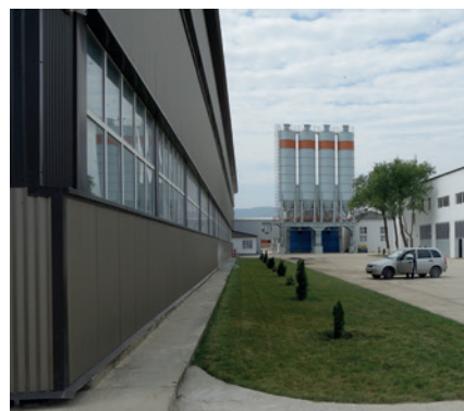
Фасад здания с БСУ
