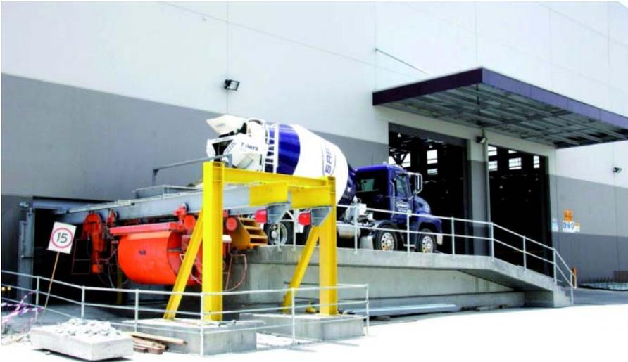
Подача бетонной смеси в ковшовый транспортер из автобетоносмесителя
