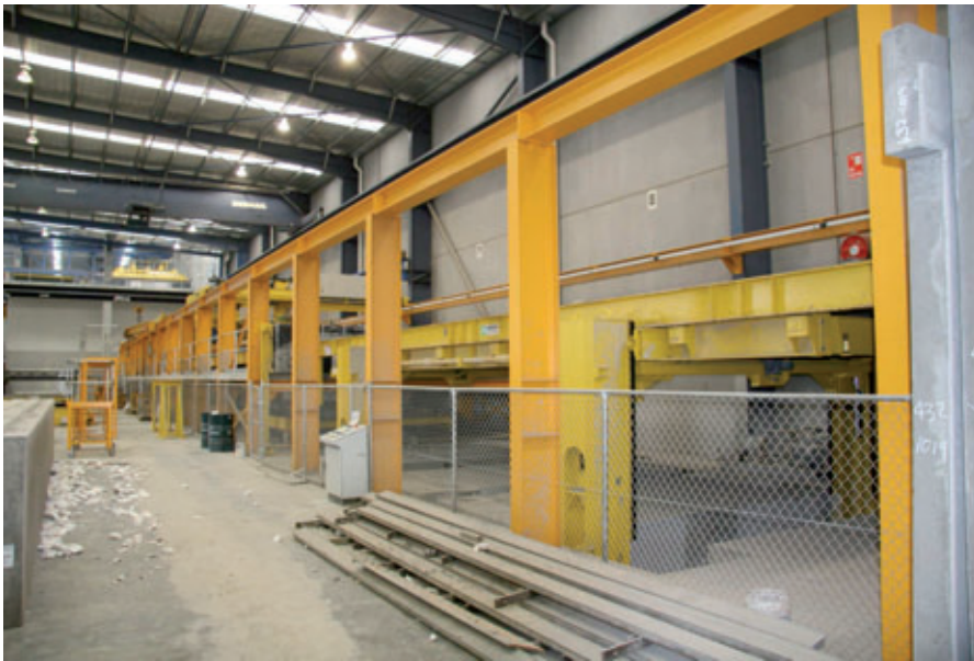
Túnel de curado previo y estaciones de alisado
