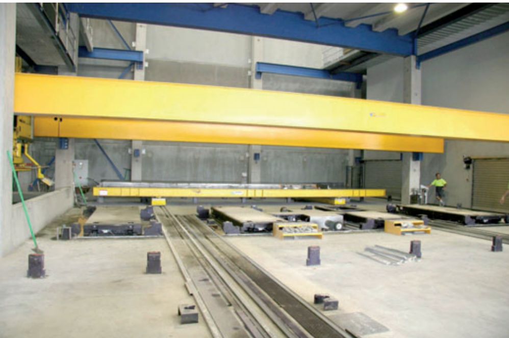
Transporte transversal entre el distribuidor de hormigón y el compactador por vibración
