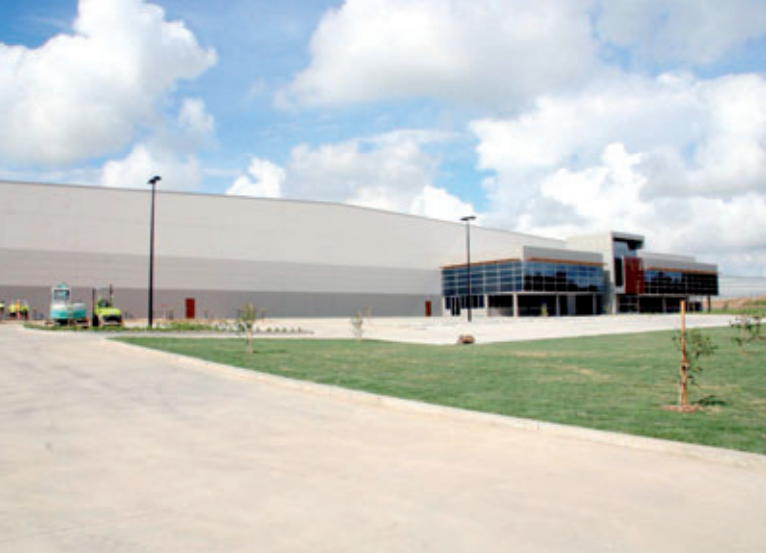
Ejemplo de una nave comercial de prefabricados suministrada y montada por Sasso
