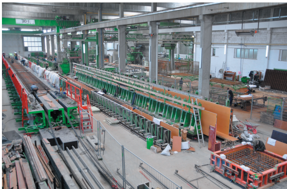
Модернизация производственной линии была поручена Avermann Betonfertigteiletechnik GmbH & Co. KG
