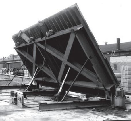
Kipptischkonstruktion bereits mit Kreuzdiagonalen
