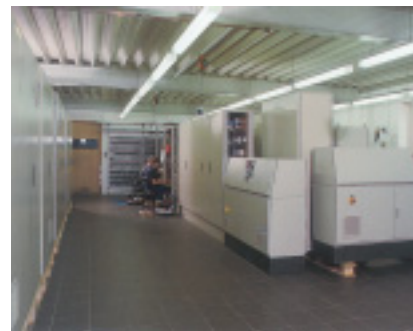
Bau und Einbau der Steuerung
