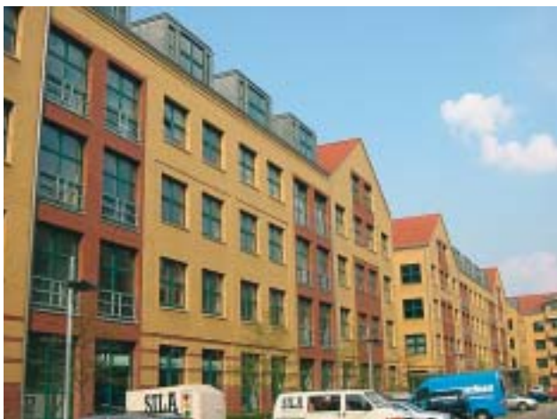
Fassadenelemente in Sandwichbauweise mit Klinkervorsatzschale
