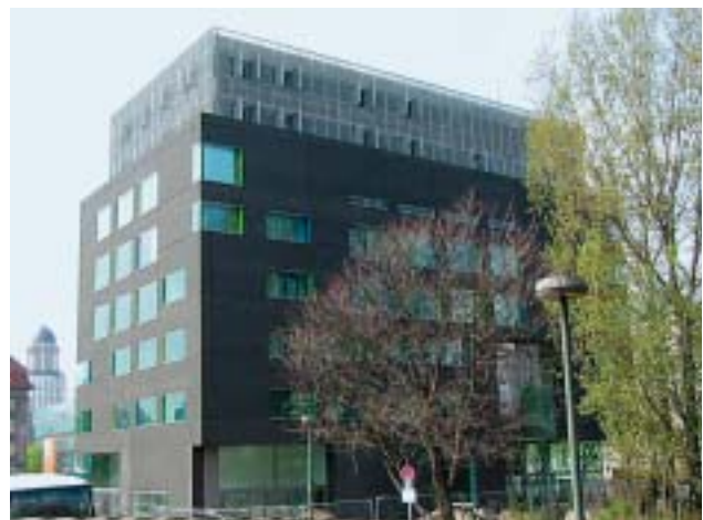
Fassadenelemente in Sandwichbauweise mit Waschbetonvorsatzschale
